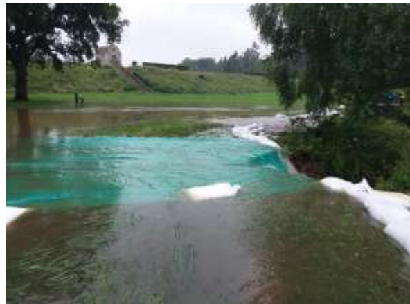
Surverse avec bâche plastique et sac de sable
